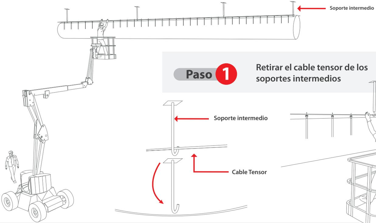
**Paso 1** Retirar el cable tensor de los soportes intermedios
