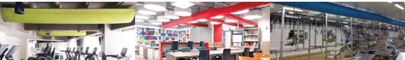
Utilizado en áreas donde se desea un espacio cómodo y no un flujo de aire directo.
